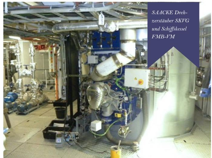
SAACKE Drehzerstäuber SKVG und Schiffskessel FMB-VM
